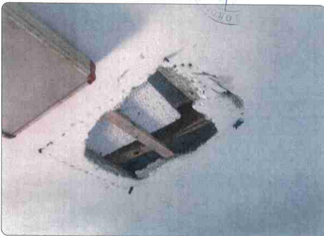
Particolare del controsoffitto sfondato del solaio della Stanza 3 al piano secondo
